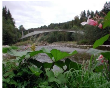
Abb. 59: Maillarts Rossgrabenbrücke (national) (Foto Fotothek Gantrisch)
