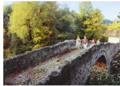
Abb. 60: Alte Schwarzwasserbrücke (national) (Foto www)
