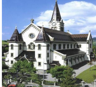
Abb. 54: Pfarrkirche in Plaffeien (national) (Foto www)
